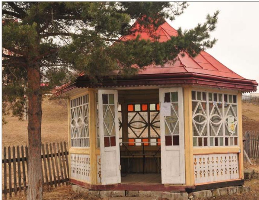
Exemplu pozitiv de stație de autobuz din lemn
